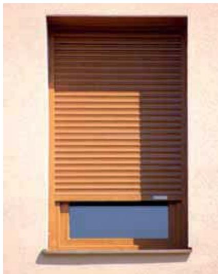
Sind die ideale und eleganteste Variante auf dem Markt und kommen vor allem bei Neubauten und Renovierung von Bauobjekten zum Einsatz. Der Rollladen-Kasten ist direkt an der Wand über der Fensteröffnung montiert und verputzt und in keinerlei Weise sichtbar. Auch die Integrierung von Rollnetzen direkt in den Rollladen-Kasten ist selbstverständlich möglich.
