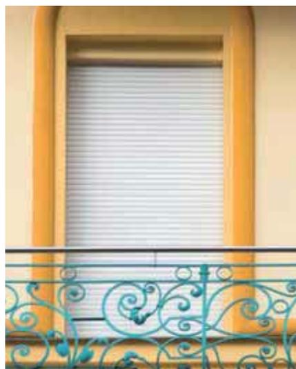
Das Rollladensystem mit Kasten wird im Wohnraum zwischen Fenster und der Oberseite der Fensteröffnung eingebaut. Die Montage dieses Kunststoff-Kastens erfolgt noch vor dem eigentlichen Einbau des Fensterrahmens. Der Rollladen-Kasten ist mittels Polystyrol-Einlage isoliert und mit einer Wartungsklappe ausgestattet.
